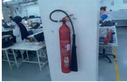
مطفأة حريق من نوع CO 2 لإخماد حرائق المعدات الكهربائية والسوائل القابلة للاشتعال
