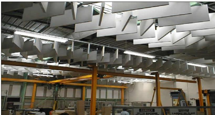
**Figure 7** : Plafond traité moyennant des baffles suspendus (photo ISST)
