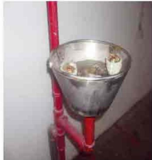
**Fig.2 : Douche de sécurité non conforme**
