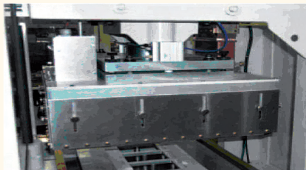
Photo 1 : Exemple de blindage d'une zone de soudage
